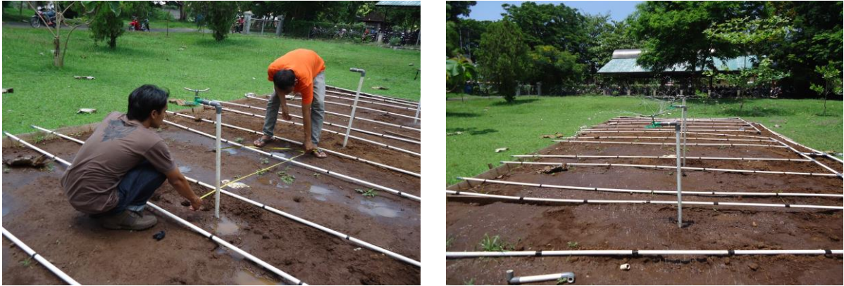
Gambar 3. Persiapan dan Pengujian Sprinkle Mini
